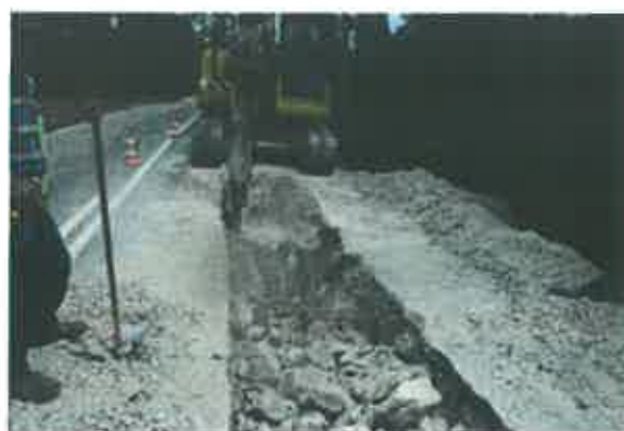
Foto 1 - SAR Cidade - Mouços - Ligação à Alta na EN 15 - Execução da Rede de Drenagem de Esgotos da Aldeia de Sanguinhedo
