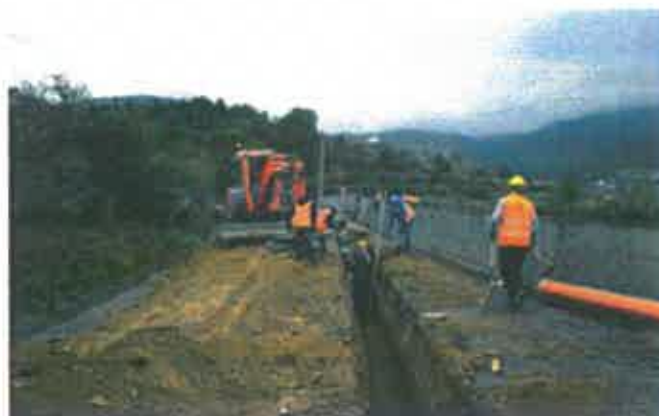
Foto 1 - Abertura de vala em Vila Cova
