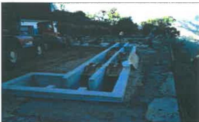
Foto 2 - Trabalhos na ETAR de Pomarelhos
