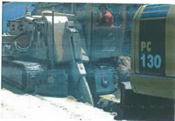
Foto 3 - Abertura de vala na R. Sta. Bárbara - Mouçós
