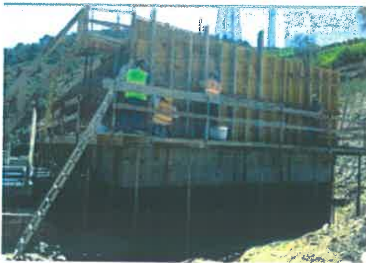
Foto 4 - Cofragem das paredes na ETAR de Nogueira
