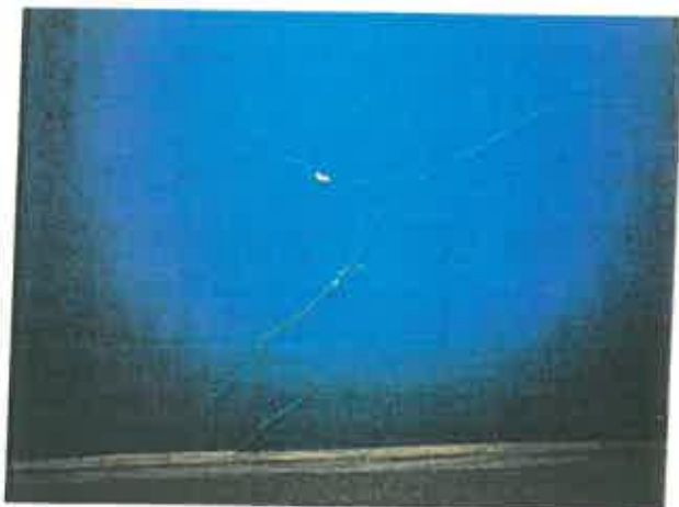
Fissuração nas paredes no grande auditório (2.09)
