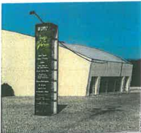
Iluminação do Totem com solução provisória de cabo suspenso até à fachada
