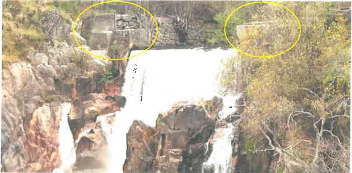
Figura 9: Patamares existentes que vão servir de apoio à nova ponte
