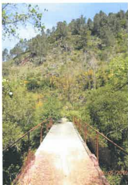
Figura 10: Ponte a reabilitar
