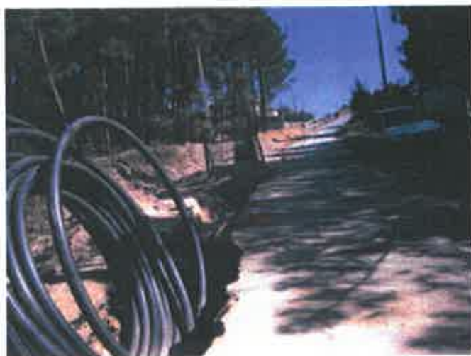
Foto 2 - Remodelação da rede de distribuição de água em Sigarrosa
