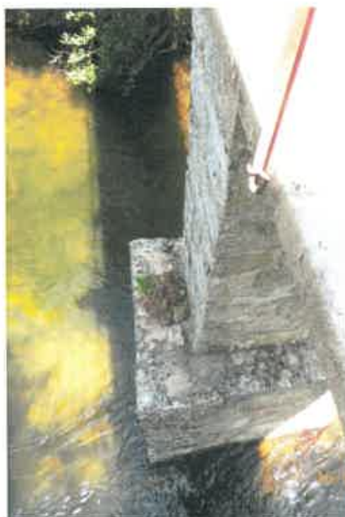
Figura 11: Pilar em pedra da ponte a reabilitar
