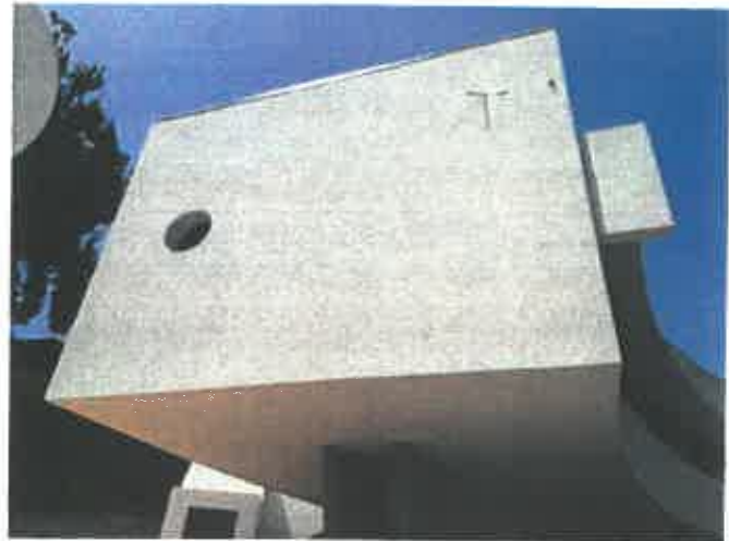
Foto 1 - Panorâmica do alçado principal do edifício das oficinas
