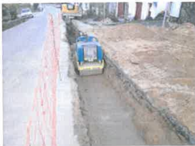
FOTO 8 - COMPACTAÇÃO DE VALA EM SIGARROSA
