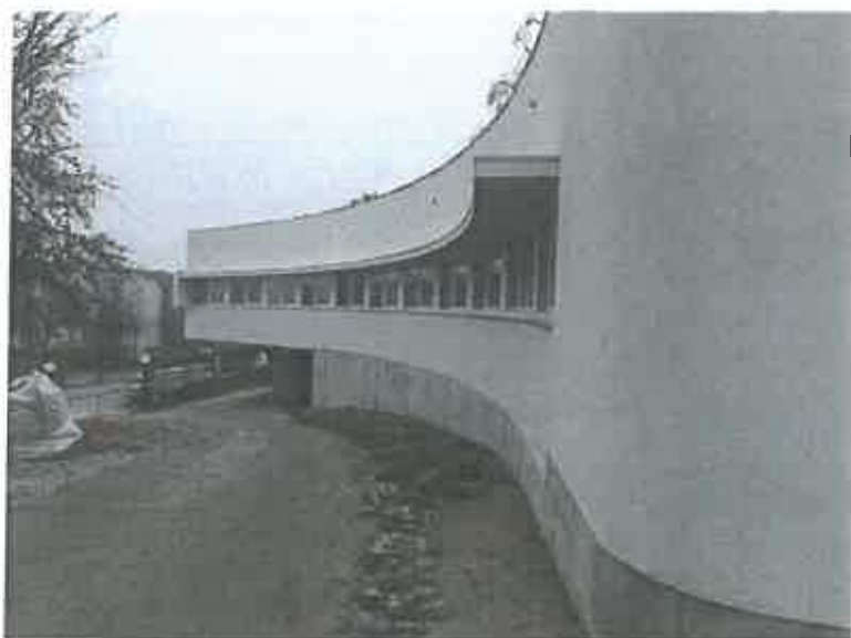
FOTO 2- ASPETO EXTERIOR DO NOVO EDIFÍCIO DAS OFICINAS DA EMARVR
