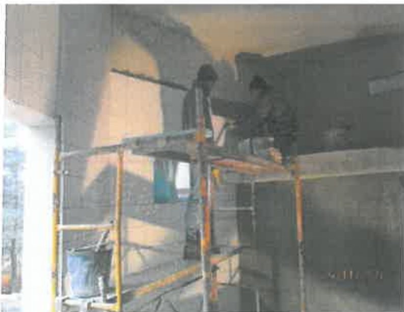
FOTO 4 - TRABALHOS NO INTERIOR DO RESERVATÓRIO DE MASCOSELO
