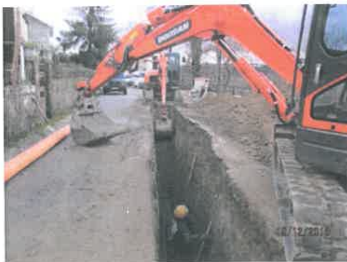
FOTO 5 - ABERTURA DE VALA EM VENDAS - CAMPEÃ
