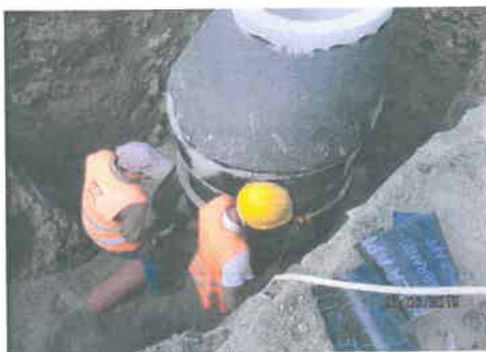
Foto 2 - Instalação de caixa de visita na Campeã
