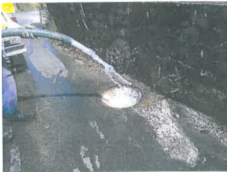
Foto 3 - Limpeza de coletor em Moções
