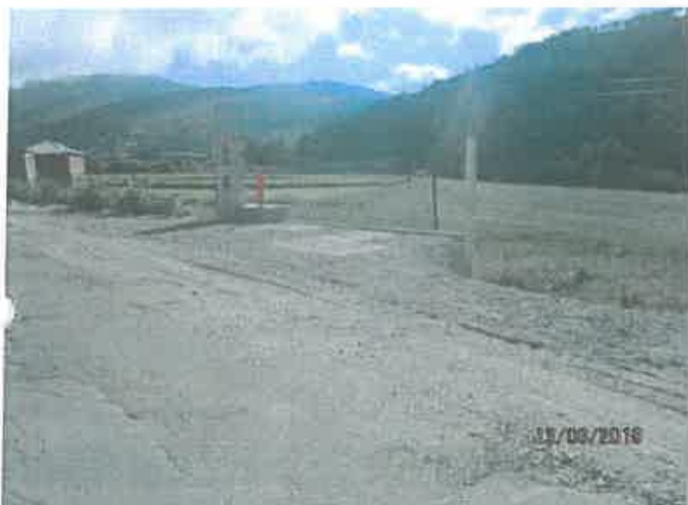
Foto 1 - Execução de ponto de entrega entre Vila Cova e Pepe - Campeã
