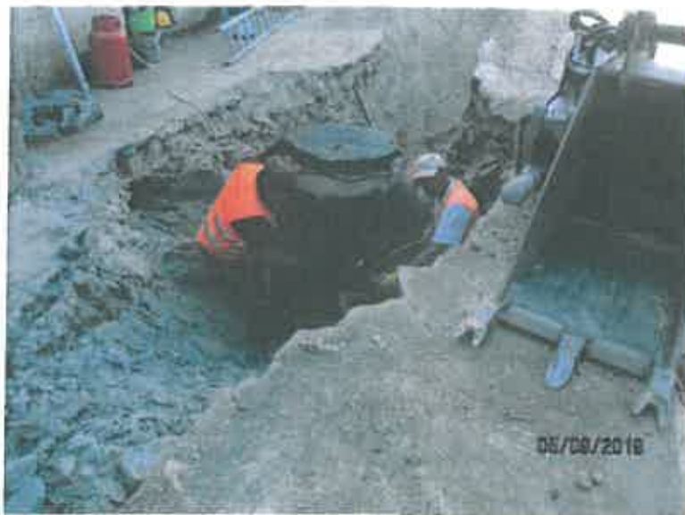
Foto 2 - Aplicação de tela asfáltica em caixa de visita
