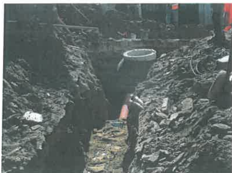
Foto 3 - Instalação da rede de drenagem de águas residuais na Campeã
