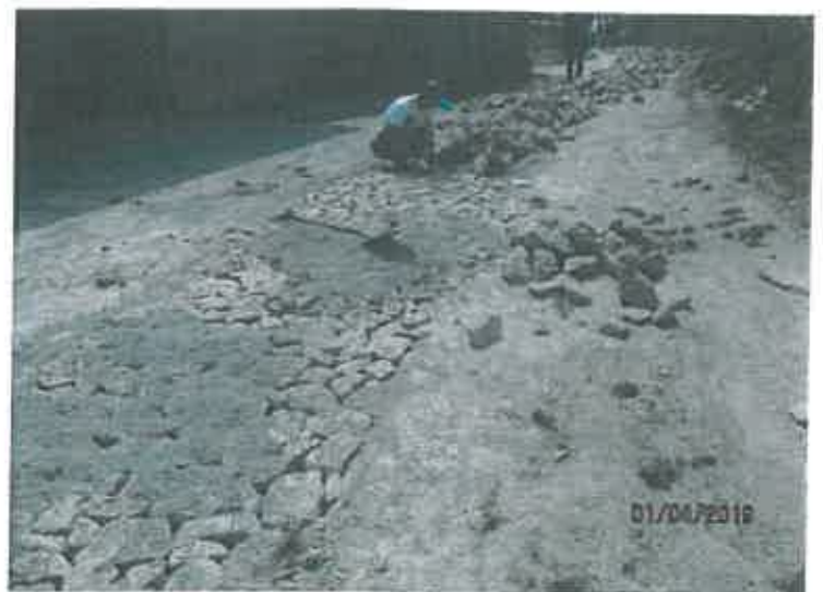
Foto 4 - Pavimentação em calçada à portuguesa
