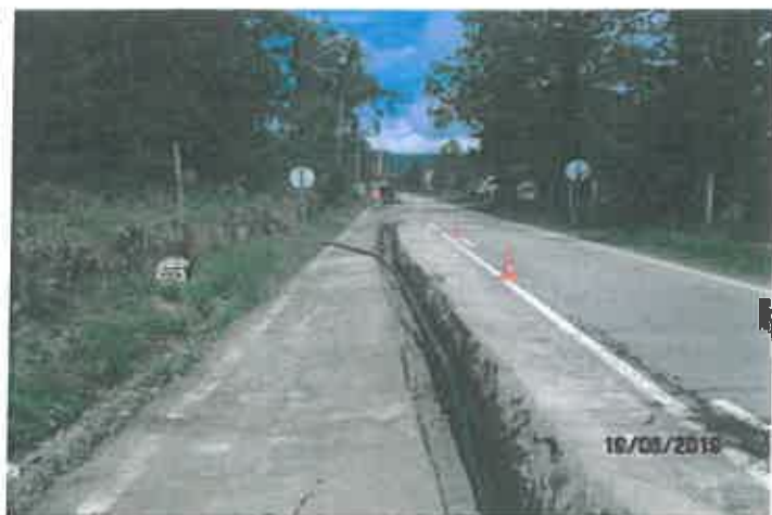
Foto 1 - Instalação de tubagem na EN304
