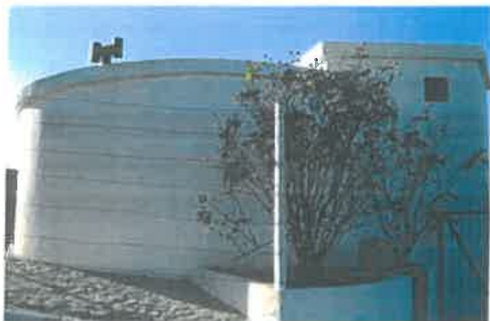
Foto 1 - Reservatório de Vilarinho de S. Romão
