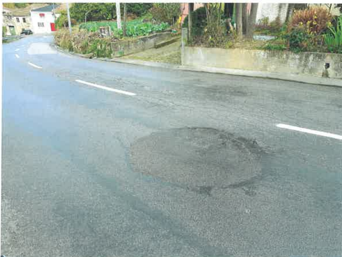
Fig 2 – Zona de Saneamento de pavimento aproximadamente ao Km 0+500
