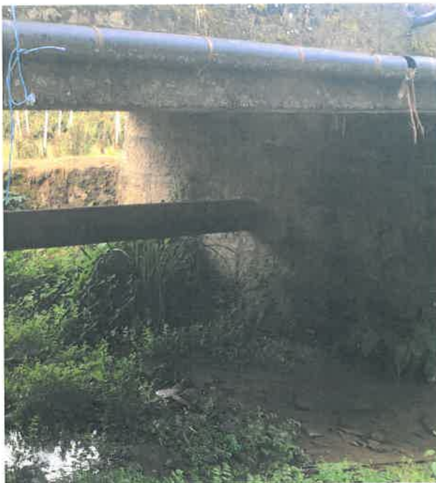
Fig. 7 – Rede de águas residuais atual, sob a ponte da Ribeira de Tourinhas.
