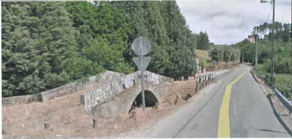
Ponte Romana (pedonal) e ponte atual a demolir
