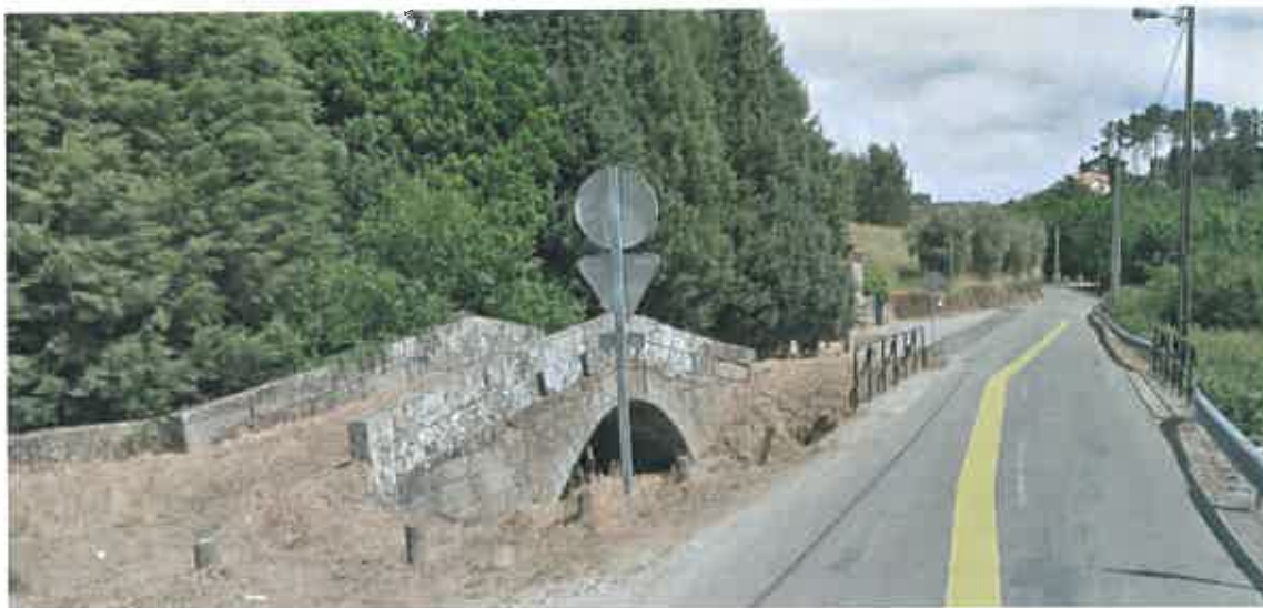
Fig1 – Ponte Romana (pedonal) e ponte atual a demolir
