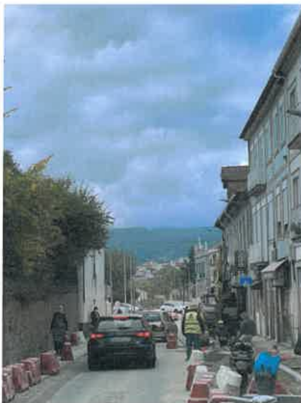
Fig. 1 – Vista geral dos trabalhos a decorrer.
