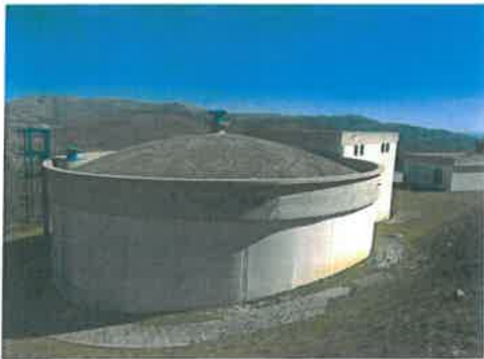
Foto 1 - Reservatório de Viariz da Poça
