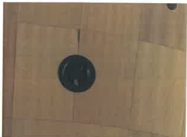
Painel deslocado sobre o palco do grande auditório (2.01)
