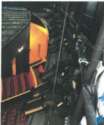
Exemplo de projetores com lâmpadas convencionais para iluminação cênica
