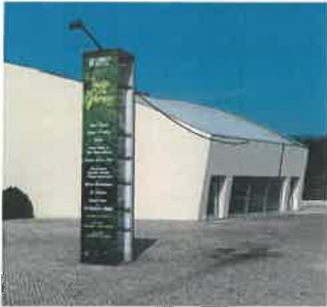
Iluminação do Totem com solução provisória de cabo suspenso até à fachada
