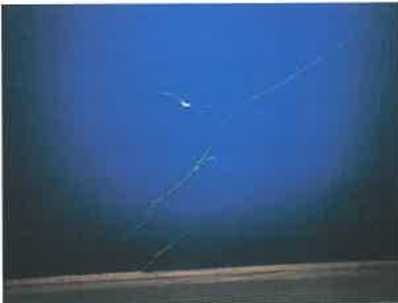
Fissuração nas paredes no grande auditório (2.09)
