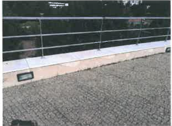
Revestimento em pedra dos muretes danificados junto à na praça cénica (3.E1)
