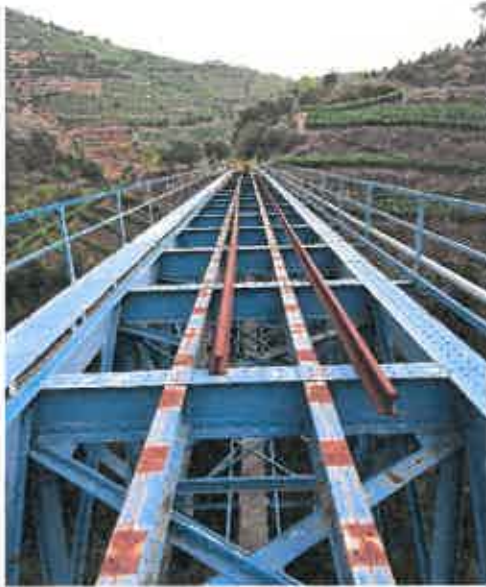
Imagem 10 - Ponte sobre o rio Tanha - Situação atual
