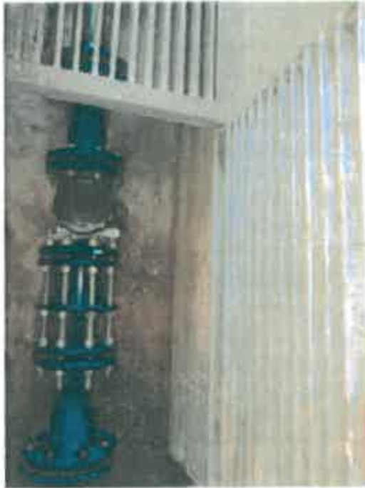
Foto 4 - Implementação de ZMC's nos sistemas de abastecimento de água do Município do Peso da Régua
