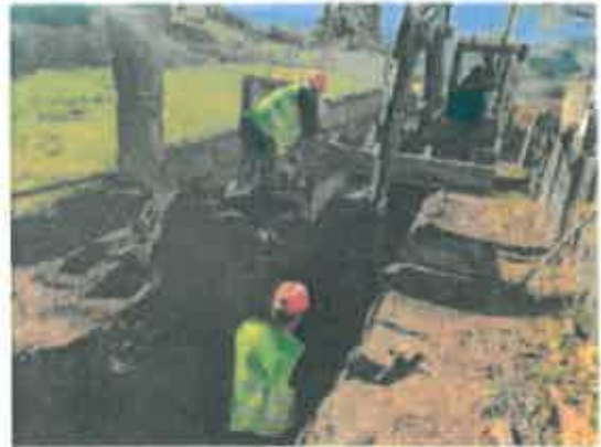
Foto 2 - Fecho de Sistemas de Águas Residuais em Vários Lugares do Município do Peso da Régua
