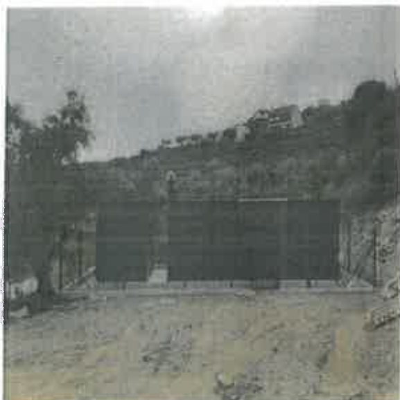
FOTO 6- EMPREITADA DE CONCEÇÃO/ CONSTRUÇÃO DE ETAR'S MBR'S - LOTE 1
