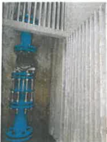
FOTO 4 - IMPLEMENTAÇÃO DE ZMC'S NOS SISTEMAS DE ABASTECIMENTO DE ÁGUA DO MUNICÍPIO DO PESO DA RÉGUA
