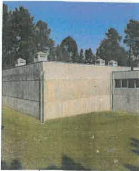
FOTO 1 - RESERVATÓRIO DE CONSTANTIM
