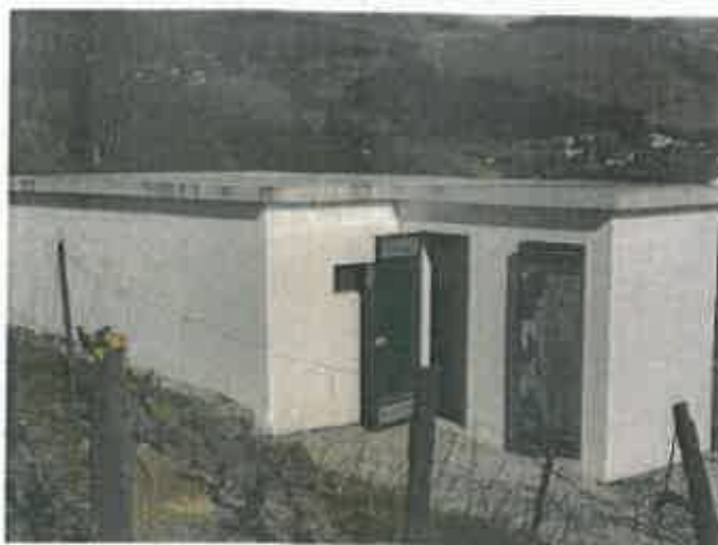
FOTO 7- RESERVATÓRIO DE TOJAIS - MESÃO FRIO
