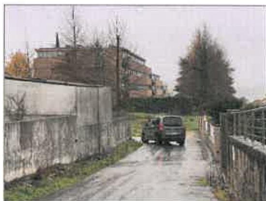
Fig. 4 – Vista do entroncamento onde existe a probabilidade de ocorrência de acidentes.
