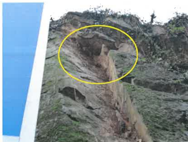
Fotografia 8 – Bloco rochoso solto em condições de equilíbrio instável.
