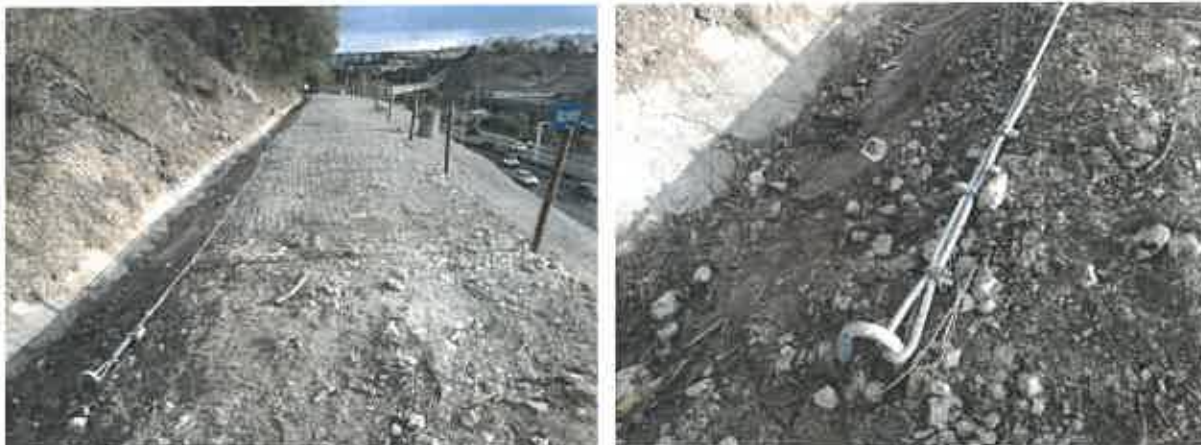
Fotografia 13 – Exemplo de cerra-cabos para aplicados em cabo de aço de ancoragem no topo de rede metálica de tripla torção
