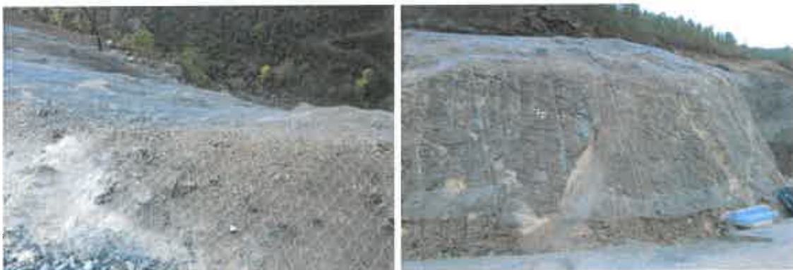
Fotografia 10 – Exemplo de aplicação de rede metálica de tripla torção: vista de topo (esquerda); rede metálica desenrolada ao longo do talude (direita).
