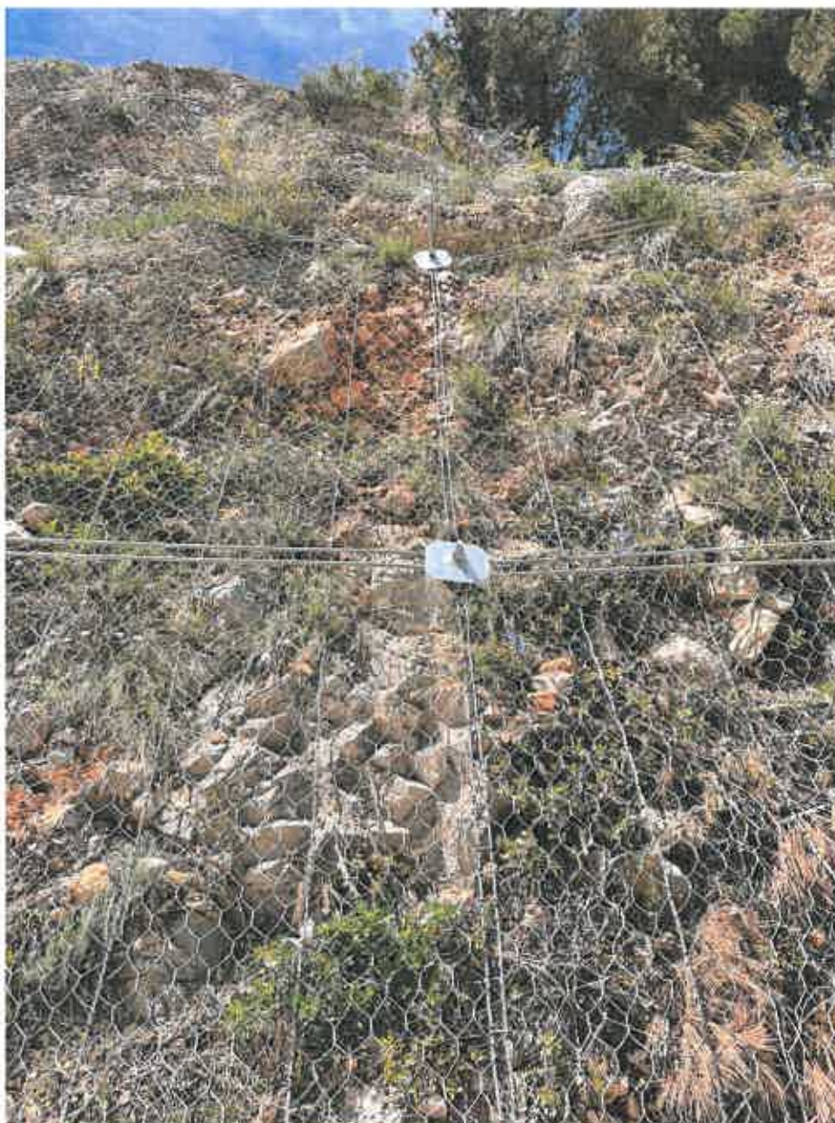
Fotografia 18 – Posição de fixação das placas de pregagem sobre rede de tripla torção.
