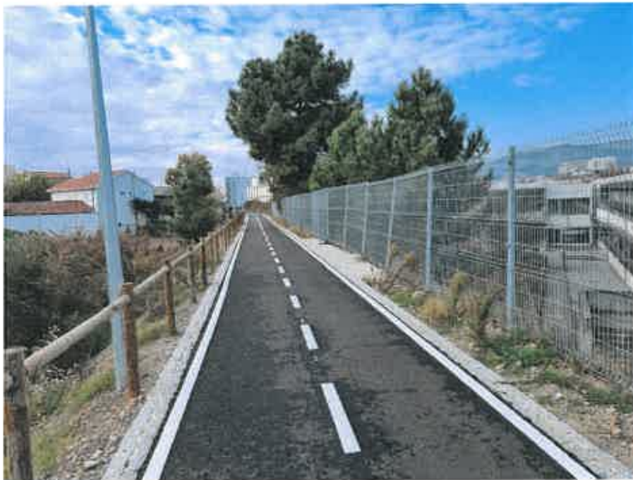
Fig. 16 Troço reabilitado da Ecopista do Corgo
