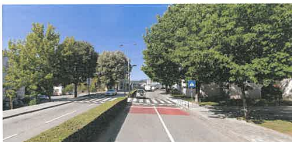
Fig. 15 Passadeiras sobrelevadas na Avenida da Universidade
