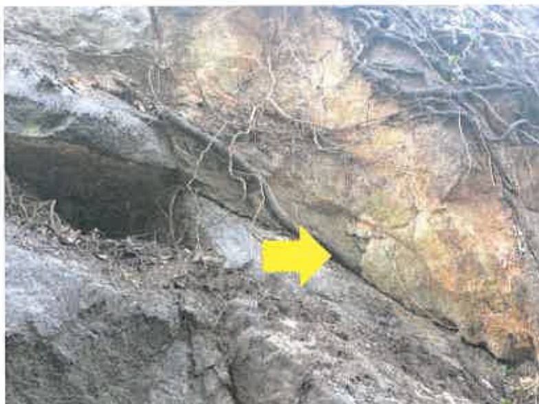
Fotografia 4 – Proliferação de raízes pelo interior de discontinuidades do maciço rochoso do talude de escavação (Geovia, 22 de dezembro de 2022)
