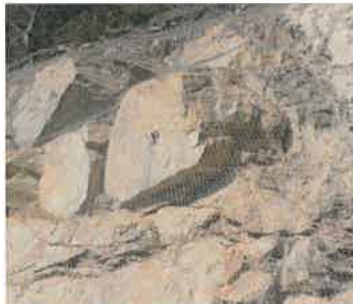
Fotografia 19 – Exemplo de aplicação de pregagem pontual em bloco rochoso em rotura por cunha.
