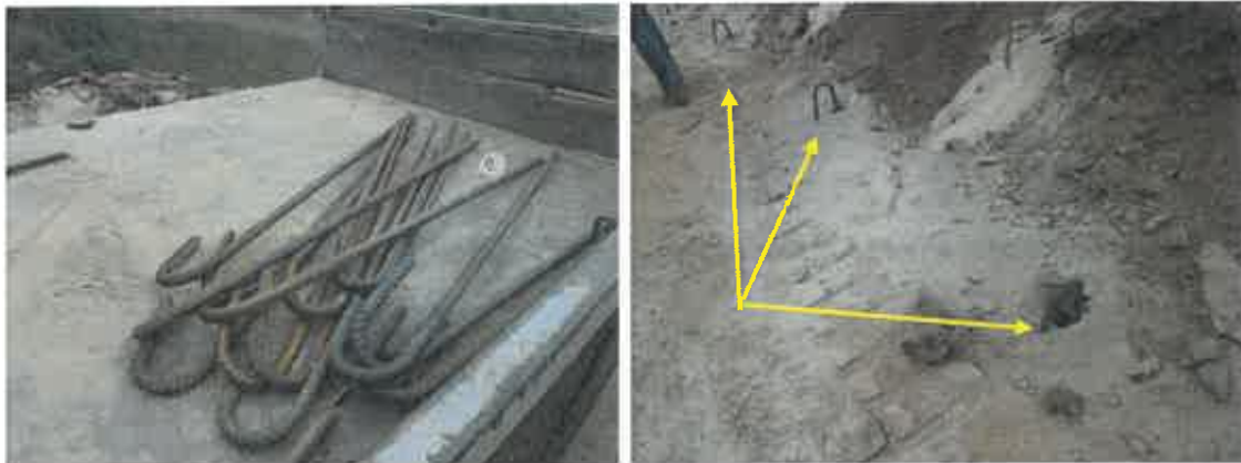
Fotografia 9 – Bengalas (varões de aço) de fixação da rede metálica ao talude.
