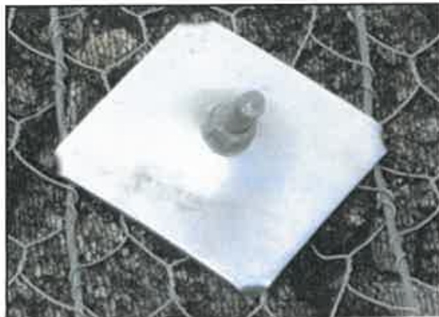
Fotografia 17 – Placa de pregagem sobre rede de tripla torção.
