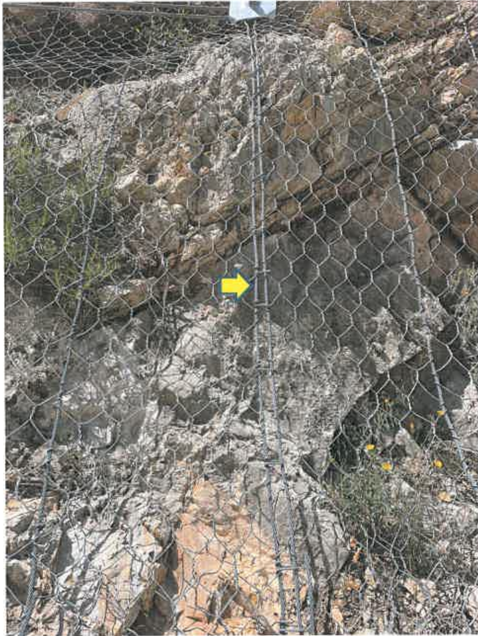
Fotografia 15 – Exemplo de aplicação de rede metálica de tripla torção e da união entre painéis adjacentes.
