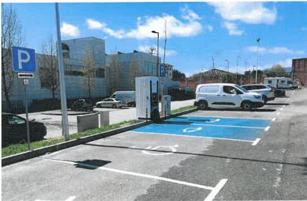
Fig. 41 Postos de carregamento elétrico no parque de estacionamento da biblioteca municipal
