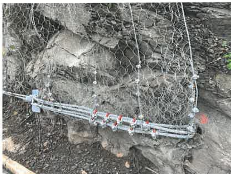
Fotografia 14 – Exemplo de cerra-cabos para aplicados em cabo de aço de ancoragem na base de rede metálica de tripla torção.
