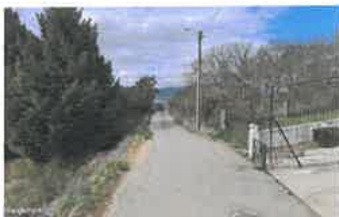
Rua do Bairro Malhor – Foto 1
