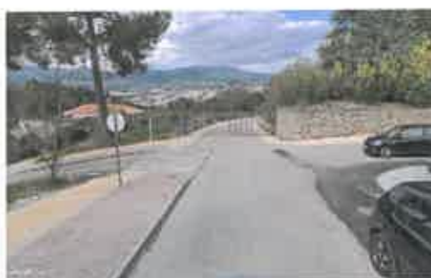
Rua do Bairro Malhor – Foto 5
