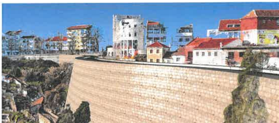
Figura 8 - Aspeto do muro em betão ciclópico, revestido em cantaria.
