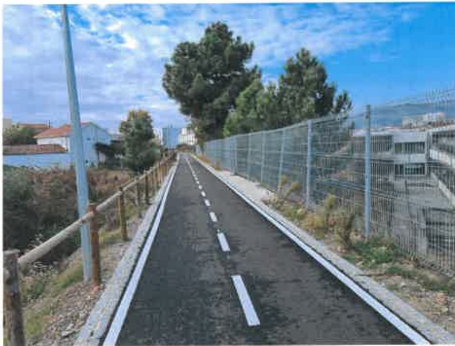
Fig. 16 Troço reabilitado da Ecopista do Corgo
