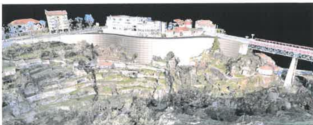
Figura 9 - Aspeto geral da inserção do muro nas escarpas do Rio Corgo.
