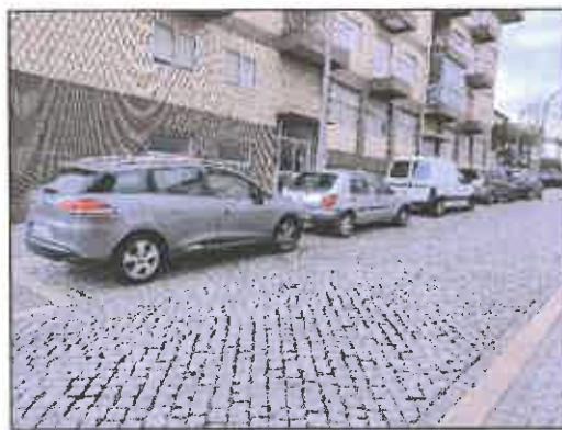
Figura 3. Baia de estacionamento existente com 5 lugares para viaturas dos árbitros e Federação Portuguesa de Futebol.
