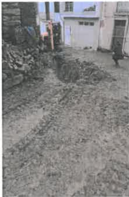
Foto 3 - Reabilitação de diversos troços de redes de abastecimento de água no Concelho de Torre de Moncorvo
