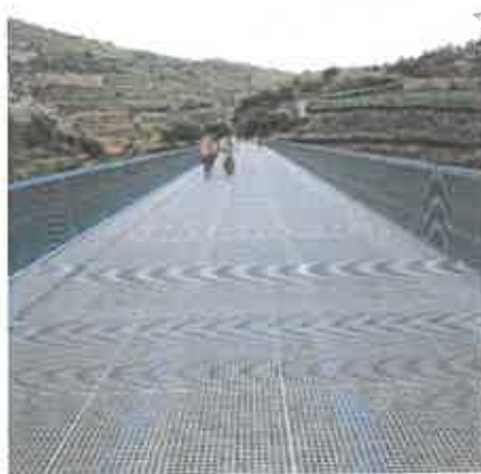
Imagem 4 – Ponte sobre o rio Tanha reabilitada
