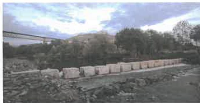
Imagem 3 – Travessia do Corgo com passagem em poldras existentes
