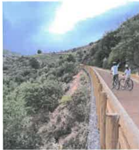
Imagem 6 – Guardas de delimitação ou guarda-corpos
