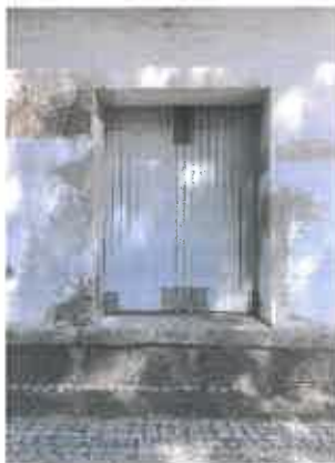
11 Portão lateral acesso hangar (em madeira, a recuperar)
