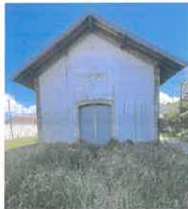
12 Portão acesso hangar (em ferro - a manter e recuperar)
