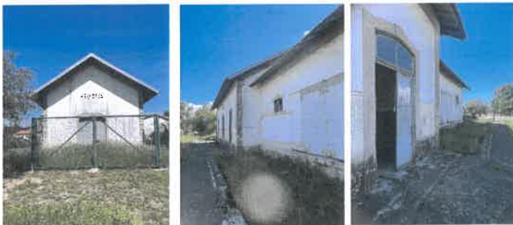
02, 03 e 04 Edifício da antiga estação de Abambres Gare – hangar- vista sudoeste e noroeste
