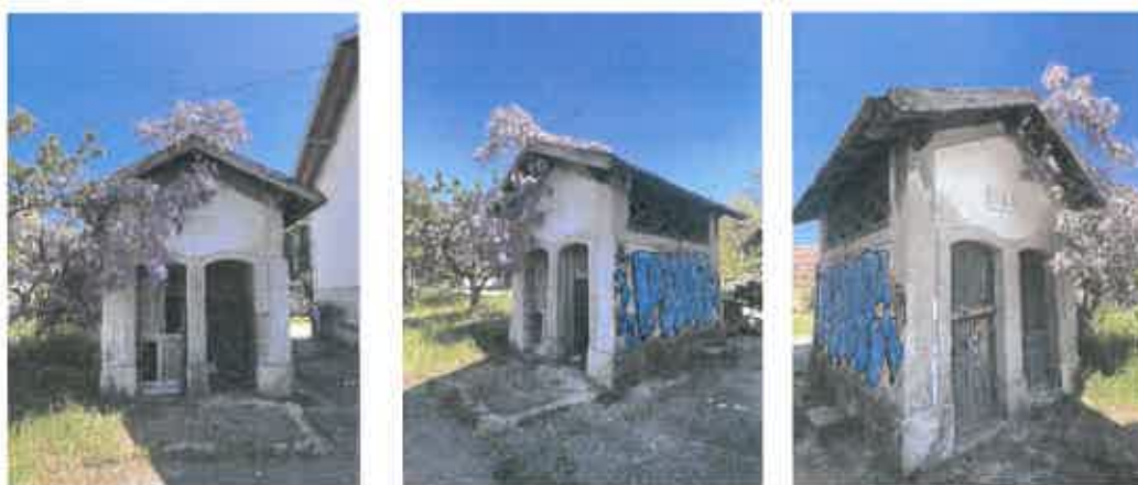
07, 08 e 09 Edifício wc exterior
