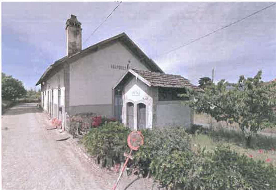
01 Edifício da antiga estação de Abambres Gare e wc exteriores – vista norte
