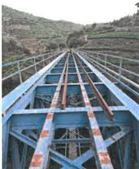
Imagem 10 - Ponte sobre o rio Tanha - Situação atual
