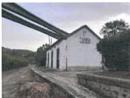
Imagem 13 - Apeadeiro do Tanha (Situação atual)
